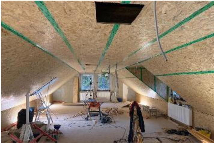
**L'étanchéité à l'air** ne nécessite pas obligatoirement une couche séparée (pare-vapeur). Elle peut également être assurée par des supports de pose, revêtements ou panneaux étanches à l'air du côté chaud.
